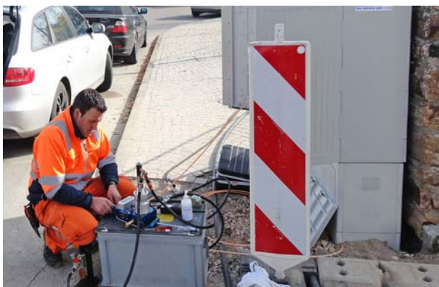
Bild 1: Hier werden Glasfaserkabel in Rohre eingeblasen.
